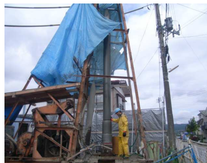
掘削用ビット 重さは1.5t
